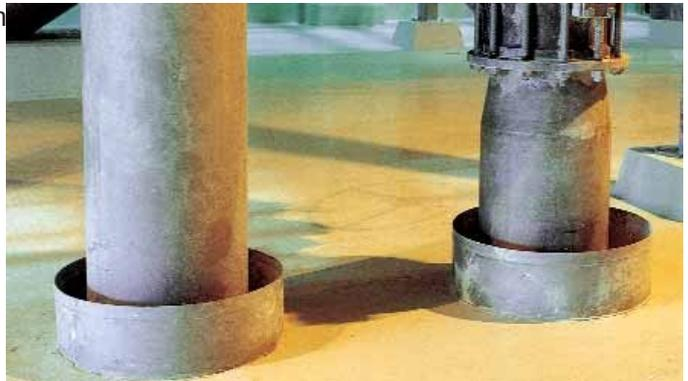
Es können ein oder mehrere Rohre durch 1 Hülse durchgef
